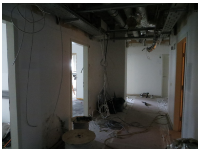
Die Sanierungsarbeiten schreiten voran.
